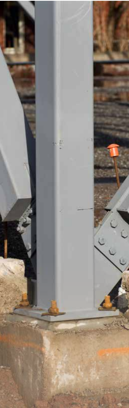
Abbildung 3 – Brandgeschützte Stahlkonstruktion mit SFRM-Beschichtungssystem Foto mit freundlicher Genehmigung von GCP Applied Technologies
